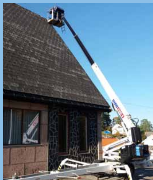
En lift måtte til da takmønet skulle repareres i høst.
